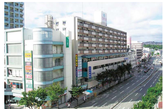
現況 第二工区側より第一工区を望む
