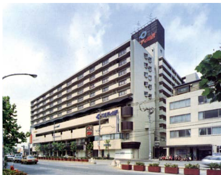
第一工区完成写真
