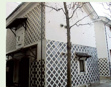
橋南第一地区の土蔵
