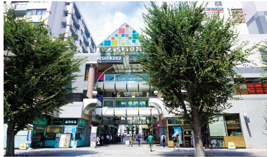
施設建築物の現在の写真
