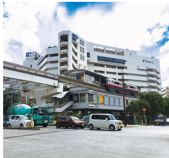
現況写真（モノレール駅と接続）
