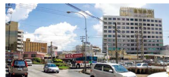
南工区の従前写真
