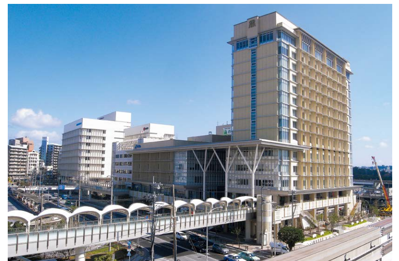
南工区の完成写真
