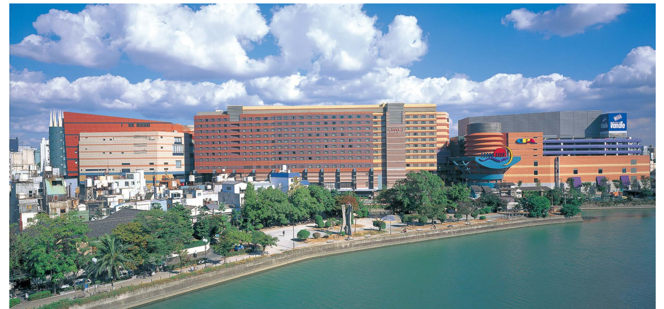
那珂川方面からの全景
