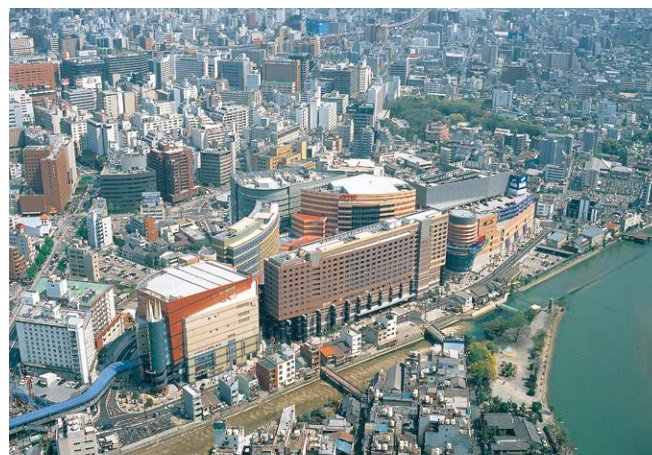
従後（写真左手に伸びる青のラインは、川端通商店街とを結ぶ歩道橋）
