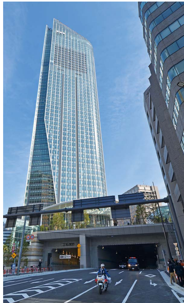
築地虎ノ門トンネル(西側端)上部の建築物
