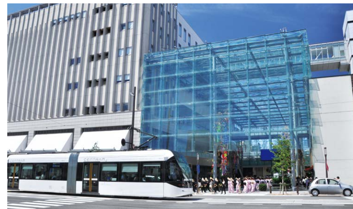
現状 事業完了後 LRT 停留所も整備
