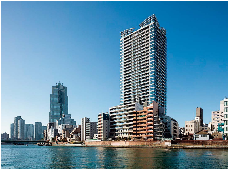
完成写真 隅田川より撮影
