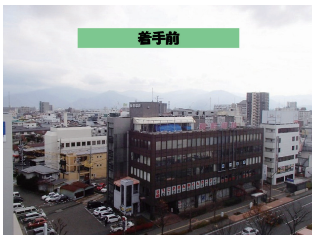
施行前の状況
