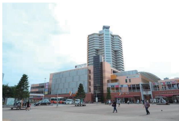
写真：整備後の全景
