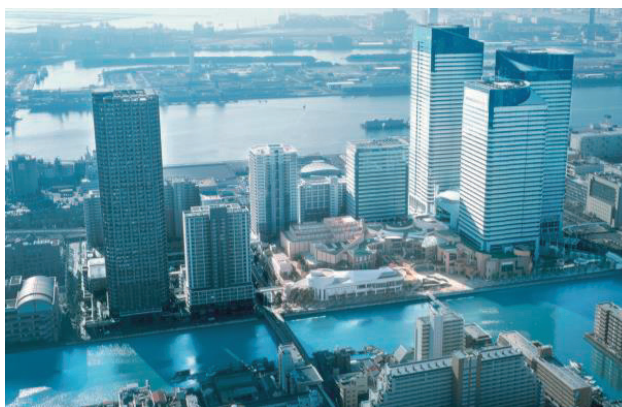
写真：整備後の全景
