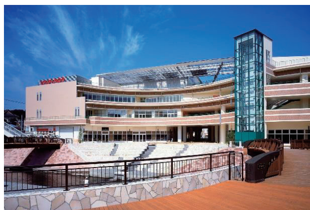
写真：整備後の全景
