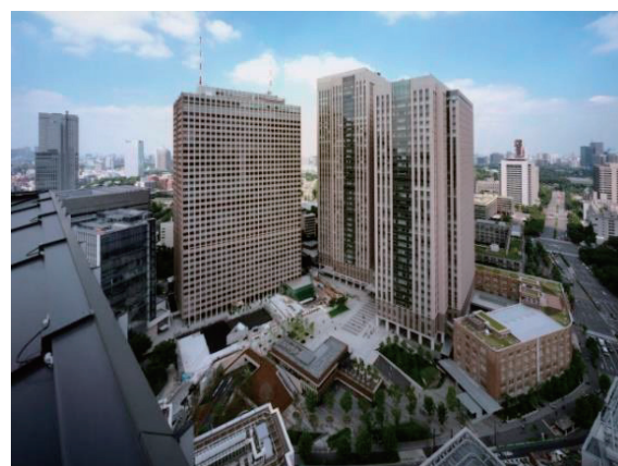
写真：整備後の全景
