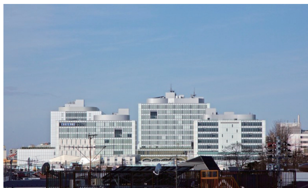
東京電機大学東京千住キャンパス 外観 ©北嶋 俊治
