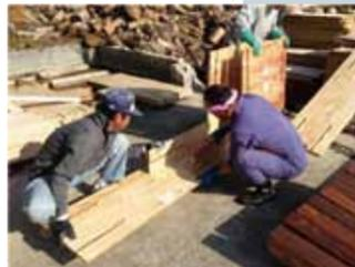
ベニアハウスは2011年の東日本大震災を機に、緊急時の仮設住宅や集いの場として活用できるように開発された「構造用合板建築」である。小林博人氏と研究会の学生らによって始動したこのプロジェクトは、合板からCNCルーターによって切り出した部材を組み立てることで、専門的な道具や知識が無くともプラモデルキットのように素早く構造フレームを構築できるシステムである。2012年には宮城県南三陸町で被災者のためのコミュニティセンターが建設され、翌年には宮城県石巻市に被災者のための集会所(漁村のための番屋)が建設されている。
