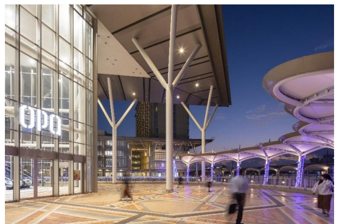
上段：建物全景 下段：歩行者デッキから
