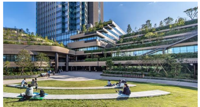
上段：施設建築物全景 下段：広場
