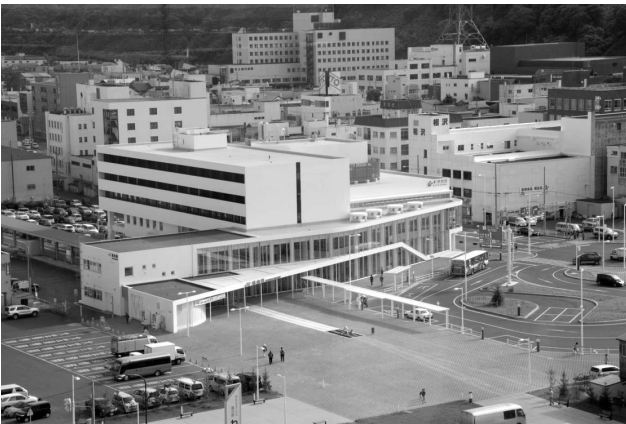
△ 竣工写真全景
