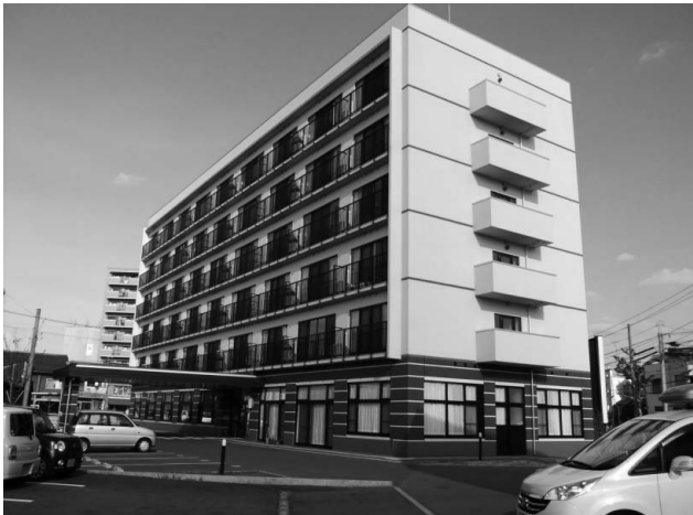
△ まちなか米子番号館
