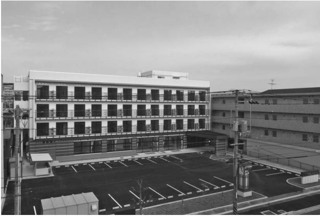
△ まちなか米子式号館
