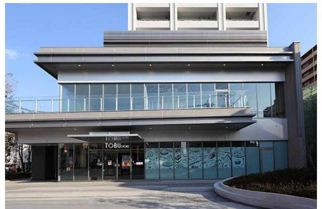
上段：施設建築物全景 下段：広場より
