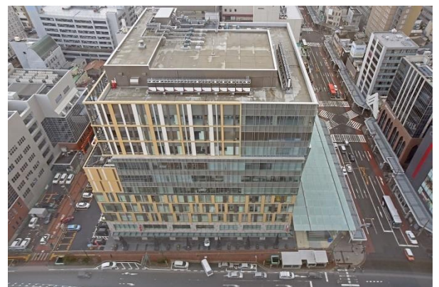
上段・中段：施設建築物全景 下段：上空より
