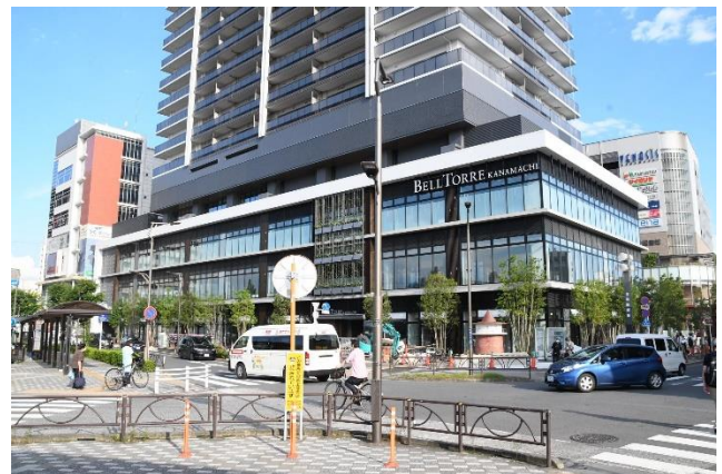
上段：施設建築物全景 下段：商業部
