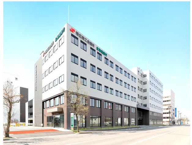
上段：施設建築物全景 下段：事務所・駐車場棟
