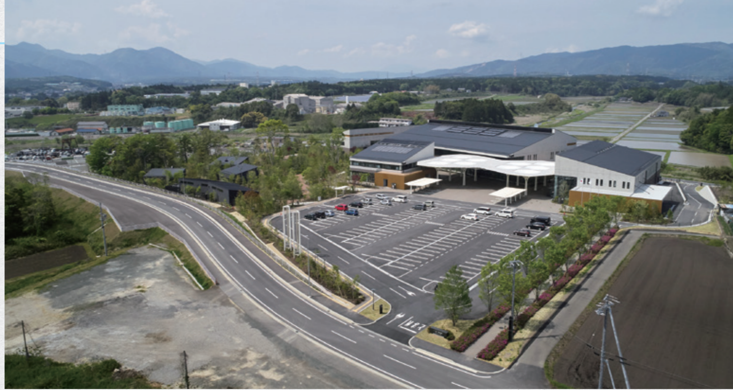
いなべ市庁舎とにぎわいの森全景
