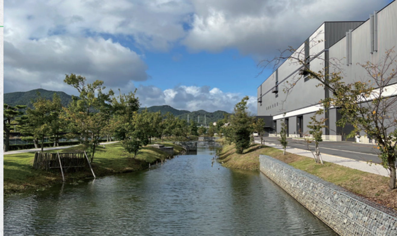
小川のように流れのある長さ約300mの調整池。多様な水生生物が息できる護岸形状である
